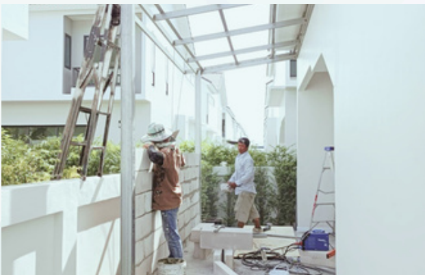
งานต่อเติมห้องครัว
