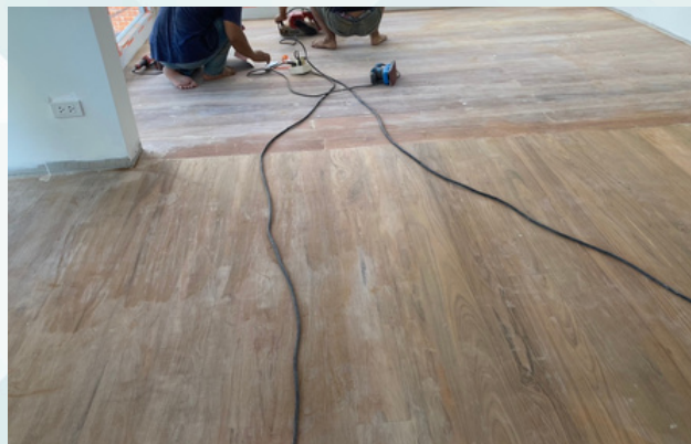
งานติดตั้งพื้นไม้
