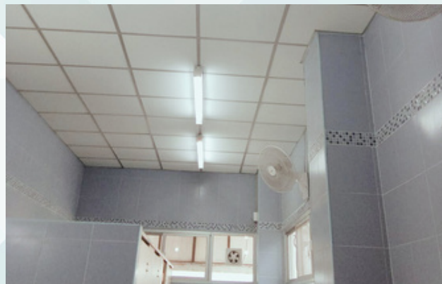
งานปรับปรุงห้องน้ำ
